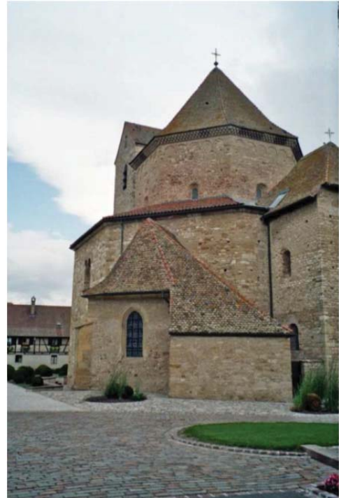
Abb. 4 Die Kirche von Ottmarsheim zeigt bis heute den achteckigen Grundriss der Gründungsanlage, typologisch angelegt an die karolingische Pfalzkapelle in Aachen. Das Damenstift ist nie zu einer grossen Abtei gewachsen und hat deshalb die ursprüngliche Struktur bewahrt.
